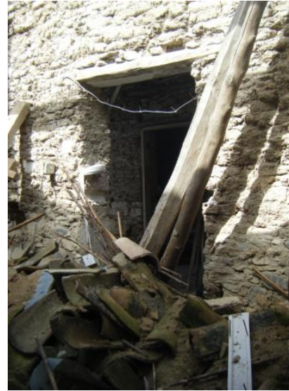
Διαχωριστικός εσωτερικός τοίχος εξολοκλήρου από ωμόπλινθους
