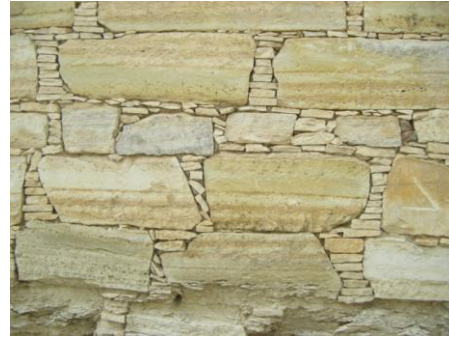
Προσεγγμένη πέτρινη τοιχοποιία από τοπική ιζηματογενή πέτρα. Συνήθως παρατηρείται μια τέτοια τοιχοποιία στις εξωτερικές όψεις των σπιτιών προς το δρόμο
