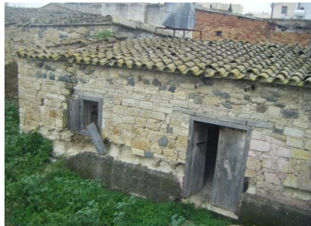
Πέτρινη τοιχοποιία σε όλο το ύψος της οικοδομής (τοπικά ιζηματογενή πετρώματα και πέτρες από το γειτονικό ποταμό)
