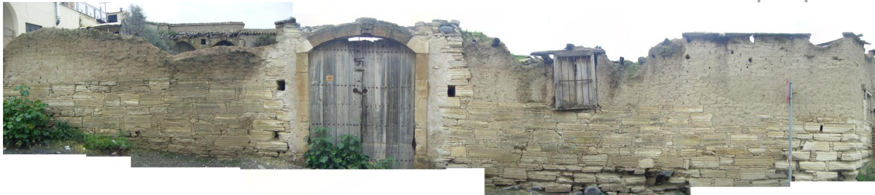
Εξωτερική όψη μαντρότοιχου – Κούφωμα πόρτας κατασκευασμένο από πουρόπετρα
