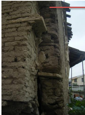
Λίθοι κανονικού μεγέθους ανάμεικτοι με μικρότερες πέτρες
