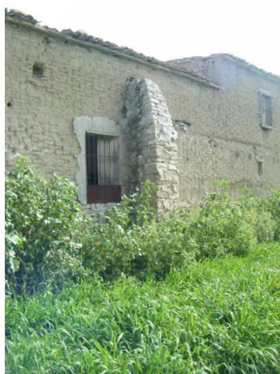
Πέτρινη αντηρίδα για στήριξη του δωματίου με μέγεθος διχώρου
