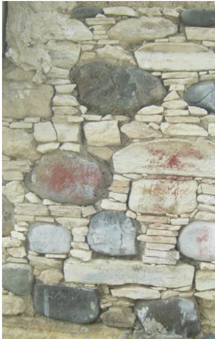
Τοπική ιζηματογενή πέτρα ανάμεικτα τοποθετημένες πέτρες του ποταμού σε όλη την τοιχοποιία
