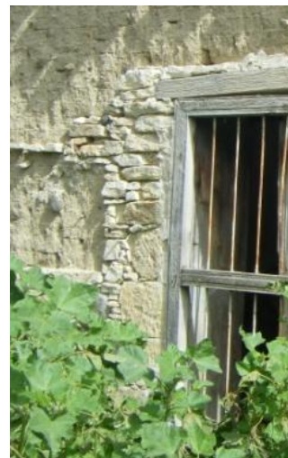
Λεπτομέρειες τοιχοποιίας γύρω από ανοίγματα
