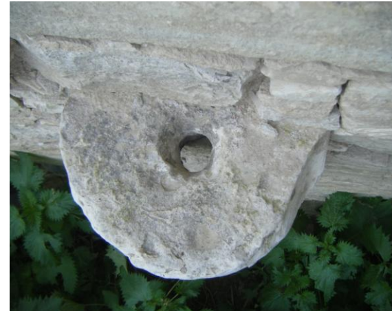
Σκαλιστή πέτρα σε εξωτερική όψη που δημιουργεί ένα σταθερό σημείο για να δένουν τα ζώα.
