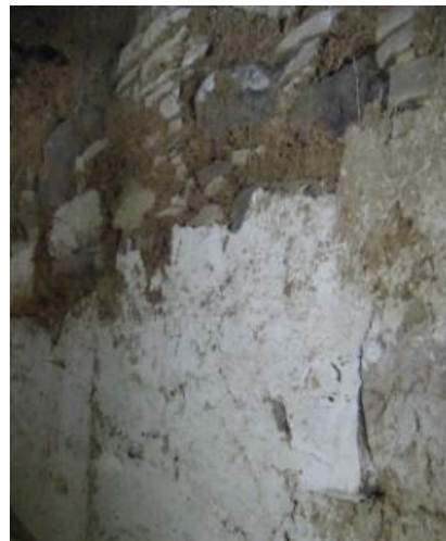
Ασβεστωμένος πηλός Επιχρίσματα τοιχοποιίας
