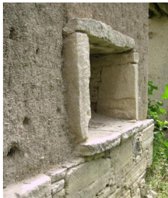
Πέτρινος κουζοστάτης σε εσωτερική όψη αυλής
