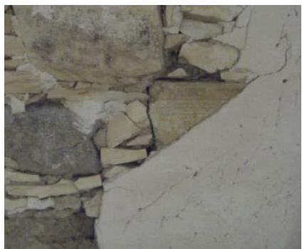
Χιλαρομένος γύψος στα εσωτερικά δωμάτια Επιχρίσματα τοιχοποιίας
