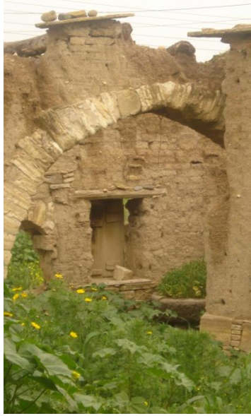
Εμφανή τα υλικά κατασκευής της καμάρας χωρίς διακόσμηση στη βάση
