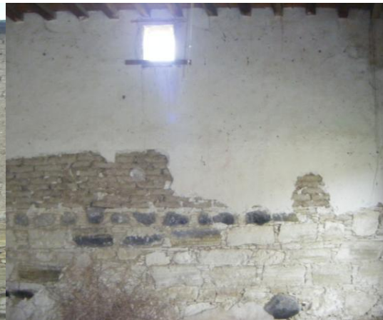
Πέτρινη τοιχοποιία στη βάση της οικοδομής (τοπικά ιζηματογενή πετρώματα και πέτρες από το γειτονικό ποταμό) και από πάνω πλιθάρια. Όλη η τοιχοποιία είναι επιχρισμένη με γύψο στο εσωτερικό
