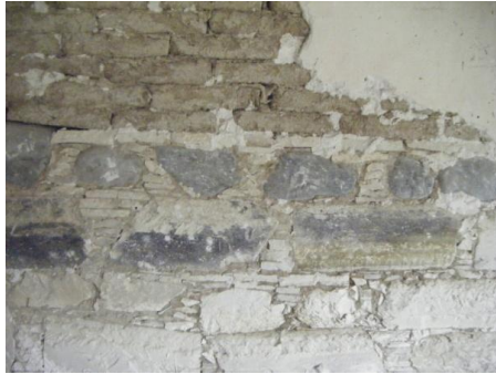
Στρώσεις από τοπικά ιζηματογενή πετρώματα και σειρά από πέτρες του ποταμού, από πάνω πλίνθινη τοιχοποιία
