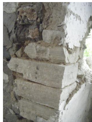
Λεπτομέρειες τοιχοποιίας γύρω από ανοίγματα
